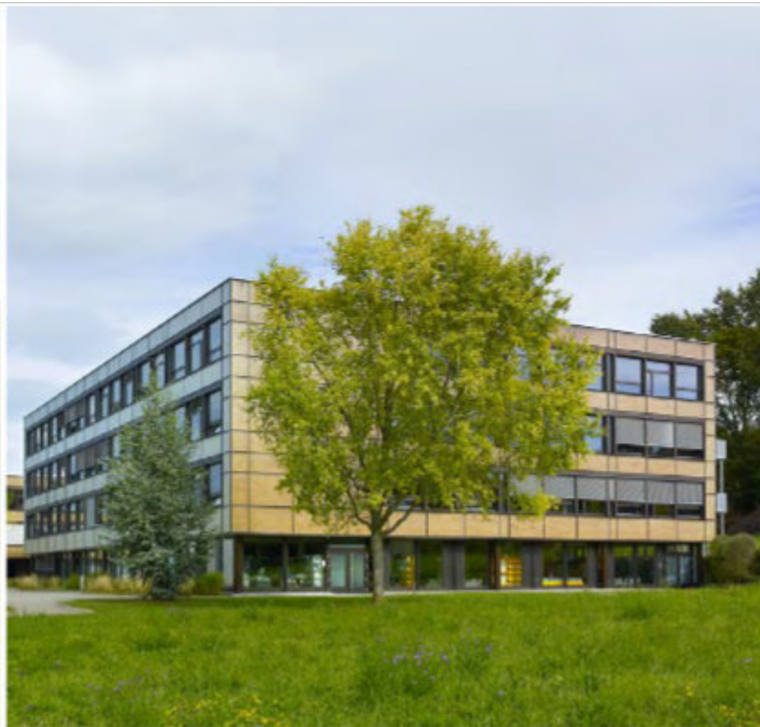
état après intervention
